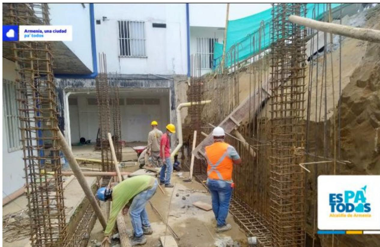
Según el cronograma establecido en la fase 1 de la ampliación, remodelación y actualización física de la Unidad Intermedia del Sur, se ejecuta la obra con una inversión de \$8.500 millones, donde se iniciaron las actividades de excavación, labores de cimentación de vigas, pilotes y dados estructurales.
